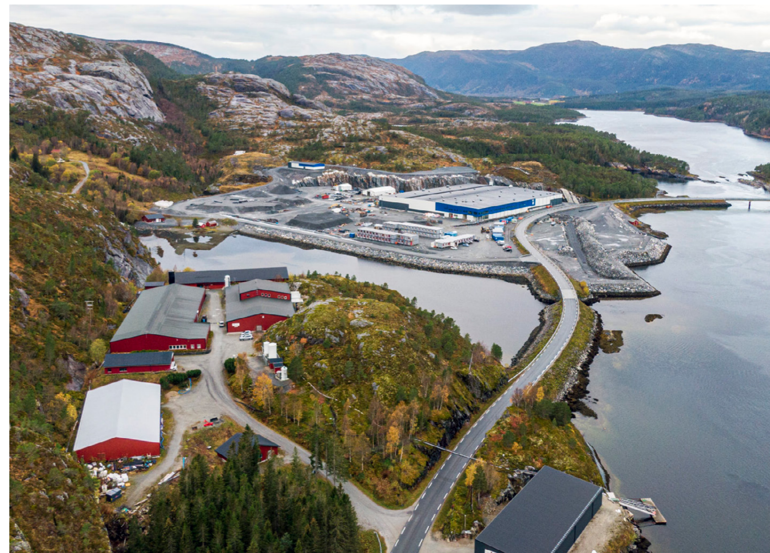
TO ANLEGG: Saglifossen (nærmest) er et tradisjonelt gjennomstrømningsanlegg, mens Svaberget (bak) har en topp moderne RAS-løsning.
